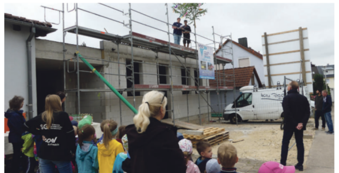
Nur wenige Monate nach dem Spatenstich wurde im Juli Richtfest gefeiert.
