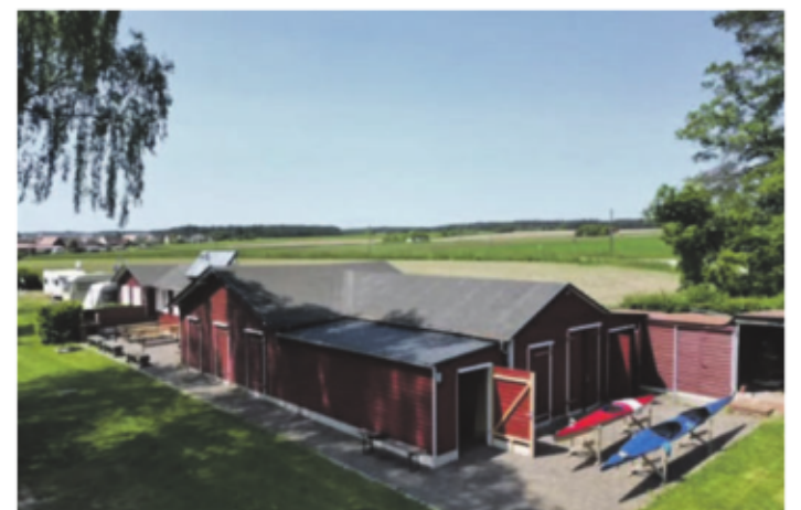
Das Vereinsheim wurde jüngst renoviert.
