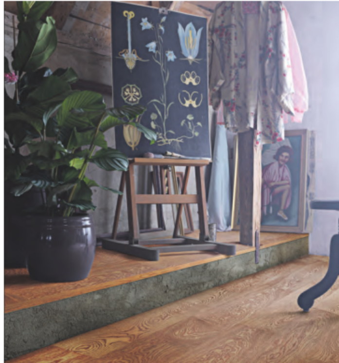
Dem Boden einfach mal einen neuen Look verleihen: Holz lässt sich staubfrei abschleifen. Beim anschließenden Oberflächen-Finish mit wasserlöslichen Lacken oder natürlichen Ölen können Farbpigmente beigemischt werden - so entstehen erfrischend neue Raumeindrücke.
